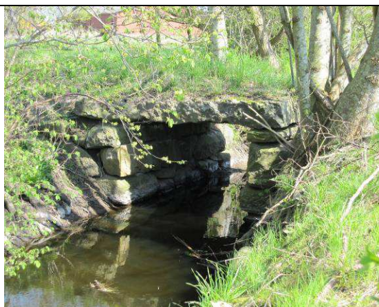
Figur 3: Stenkisteformet bro over Tåstrup Bæk. Foto: Ann Berit Frostholm
