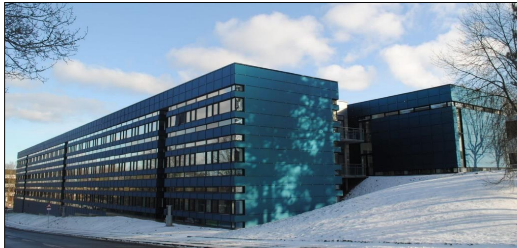
Foto: Facadesolceller på Grøndalsvej i Viby. (Solarlab)
